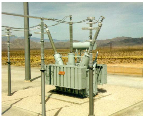
Joonis 7. 400 kV, 160 MVar šuntreaktor reaktiivvõimsuse kompenseerimiseks, selle tarbimiseks. [3]
